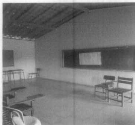
Imagem 4 – Pintura Interna Executada
