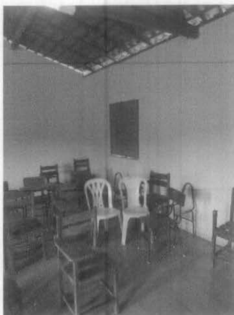
Imagem 3 – Revisão da Cobertura
