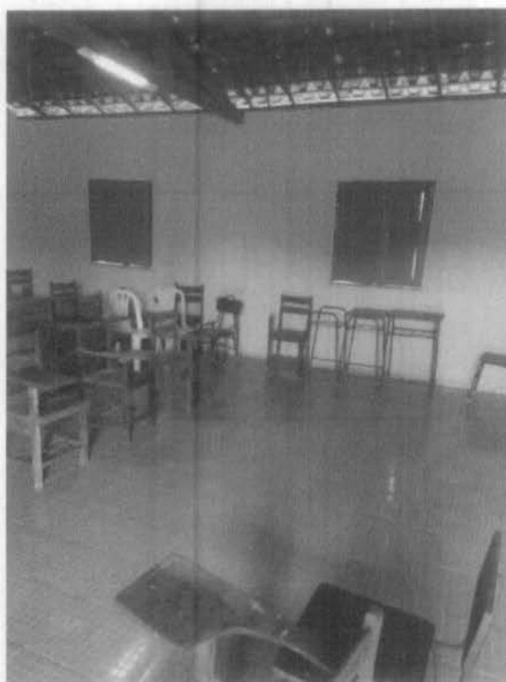
Imagem 6 – Revisão da Cobertura
